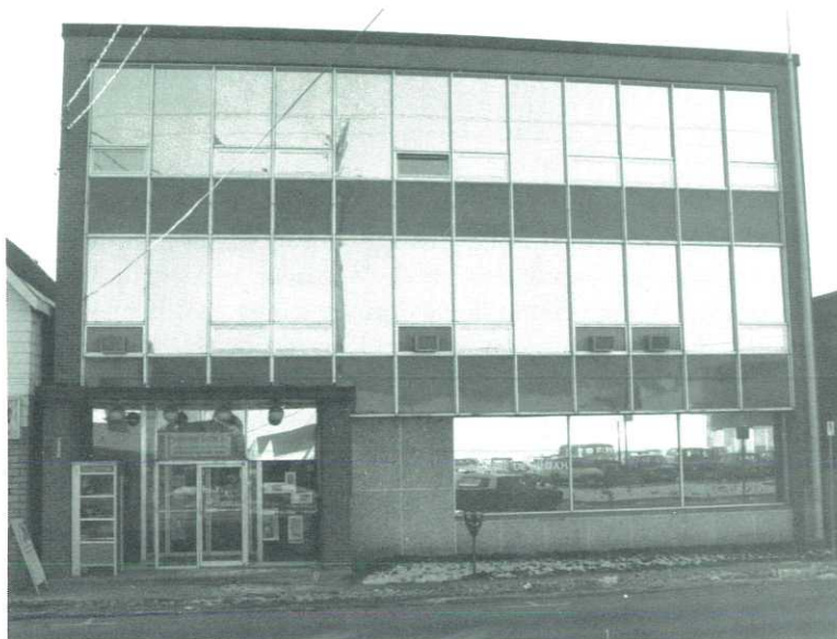
Édifice du 103 rue Moncalm à Hull, ayant servi de Palais de Justice temporaire au cours des années 1970. Photo: Pierre Bertrand.
